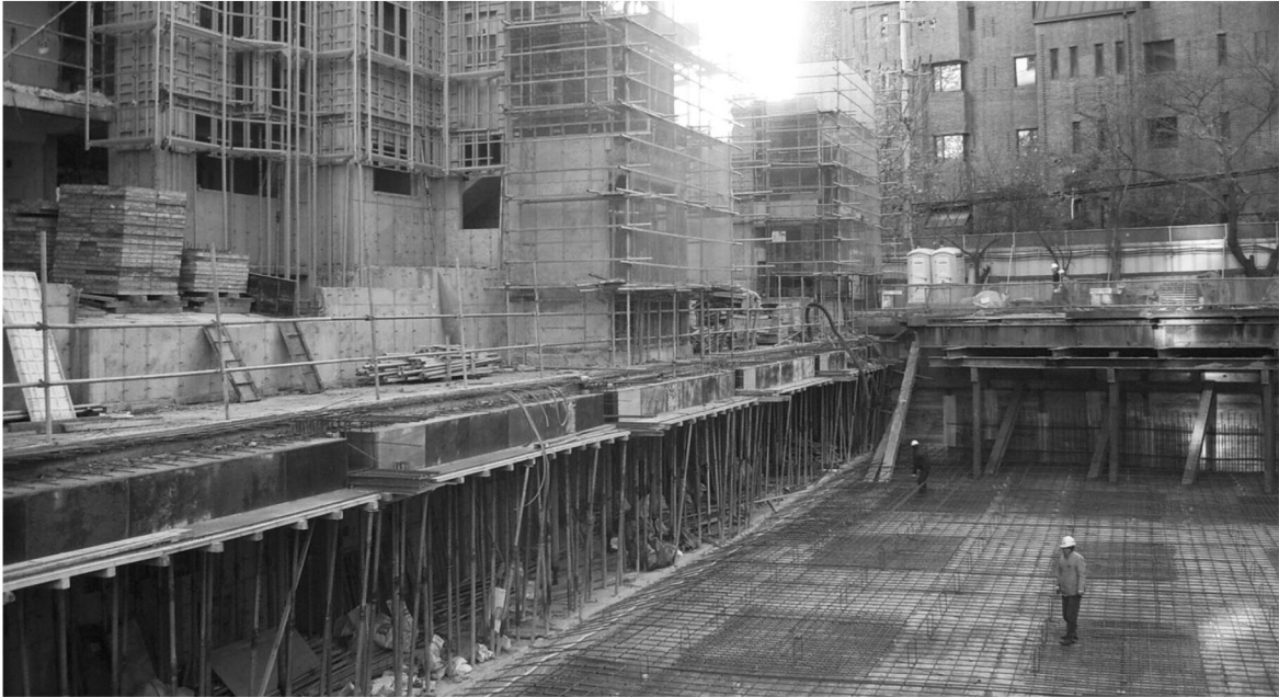
리모델링 공동주택의 지하 주차장 기초 공사.
